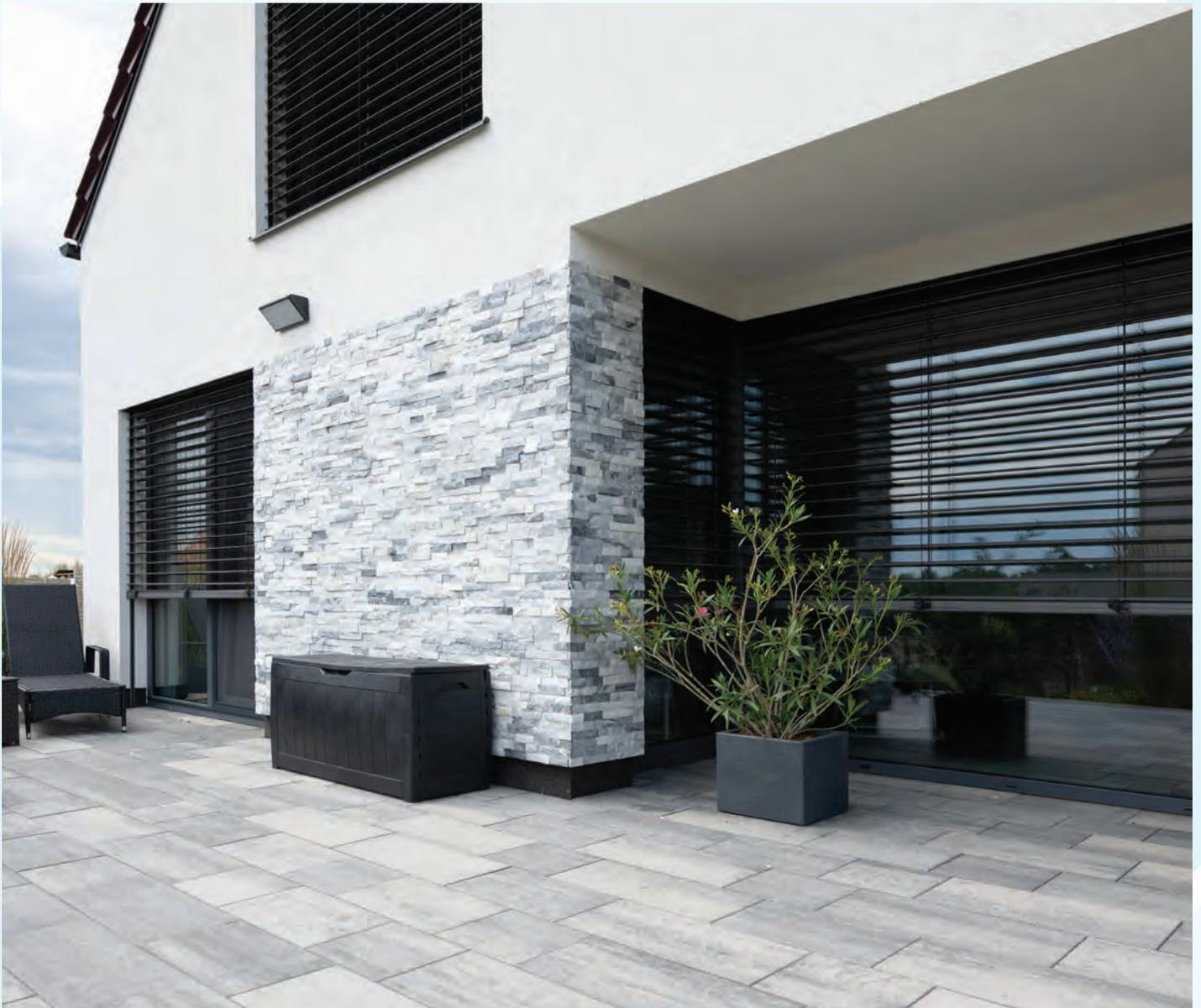
Raffstores werden in einem unter der Hausfassade versteckten Kasten installiert, der nach dem Hochziehen der Jalousie das Lamellenpaket vollständig verdeckt und die Jalousie somit in diesem Kasten gelagert und vor Umwelteinflüssen geschützt wird. Die Unterputzkästen werden immer nach Maß gefertigt und ihre Abmessungen richten sich nach der Größe des Fensters oder der Tür und dem gewählten Lamellentyp des Raffstores.
